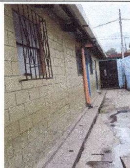
Foto 4: Cambio de bajadas de agua y canales
