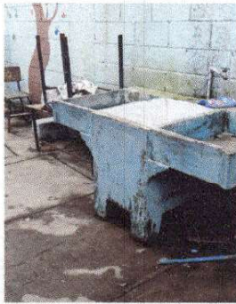
Foto 1: Se arreglo la caja de la pila y se le coloco azulejo adentro
