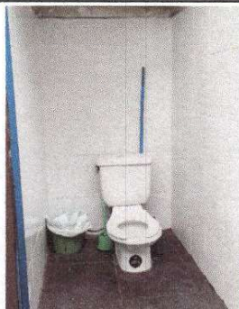
Foto 3: Cambio de sanitario, piso ceramico y azulejo
